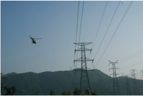
图 4 典型高压线实物图 Fig. 4 Typical HVL
